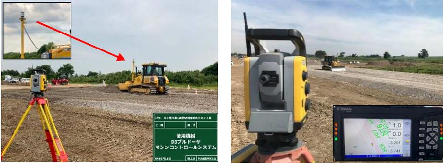
建設機械にセンサーを取付け、施工部の高さや位置を計算し、施工面のガイダンスを行います。これにより、ブレードが自動制御され、オペレーターの技量に左右されることなく、均一な敷均し作業を行うことができます。
